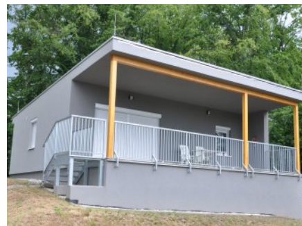
Căsuța recreativă din Jedovnice
